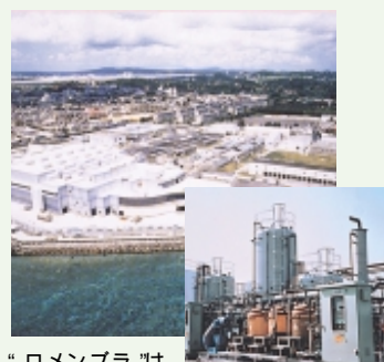
“ロメンブラ”は、沖縄県北谷(ちやたん)浄水場海水淡水化プラントに使用されています
