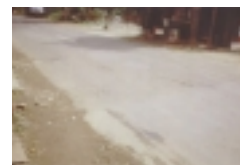
CENTEX社: 近隣道路補修後
