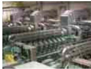
東海工場のガスコージェネレーション設備
