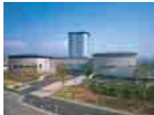
東レ総合研修センター (静岡県三島市)
