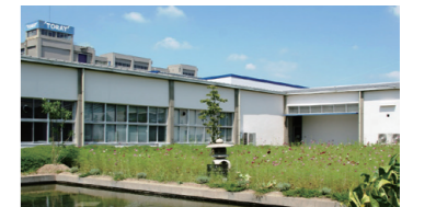
東レ(株)岡崎工場内のピオトープ
