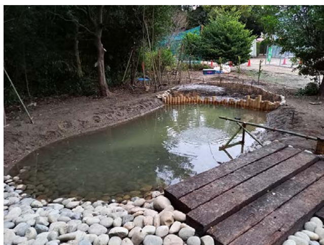
完成したビオトープ
