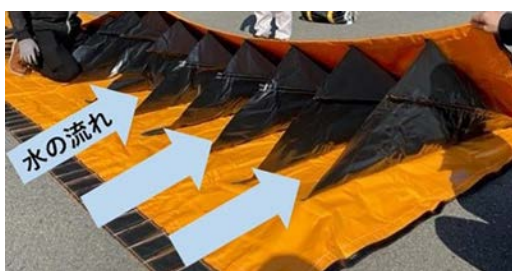
(例) ウォーターゲートの設置
